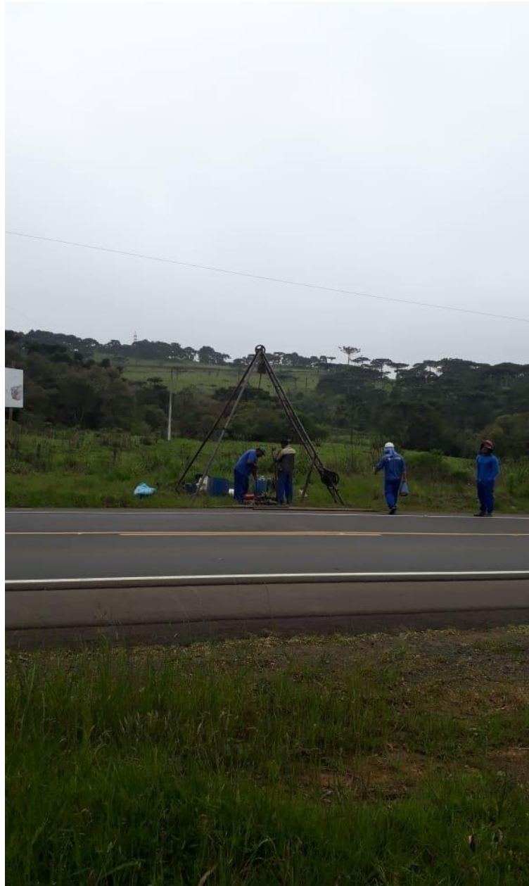
FOTO 01: Serviço de Sondagem de Solos (SPT), realizado conforme a NBR 6484
